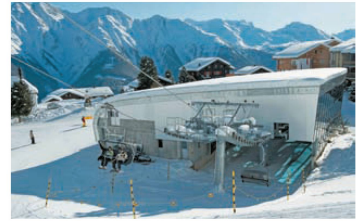
< Versteckt im Hangar: die Sesselbahn Hohfluh auf der Riederalp VS.
