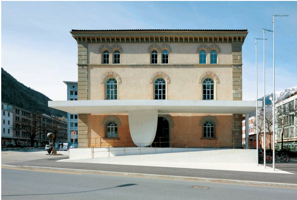
^Der Zugang zum Grossratsgebäude ist mehr Skulptur als Gebäude. Das Dach scheint auf der Wappenscheibe zu balancieren – erst auf den zweiten Blick erkennt man die Stütze rechts.
