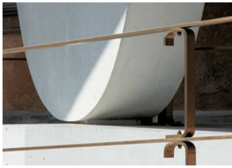
<Nun ist beim Eingang zum Grossratsgebäude in Chur wieder alles im Gleichgewicht.
