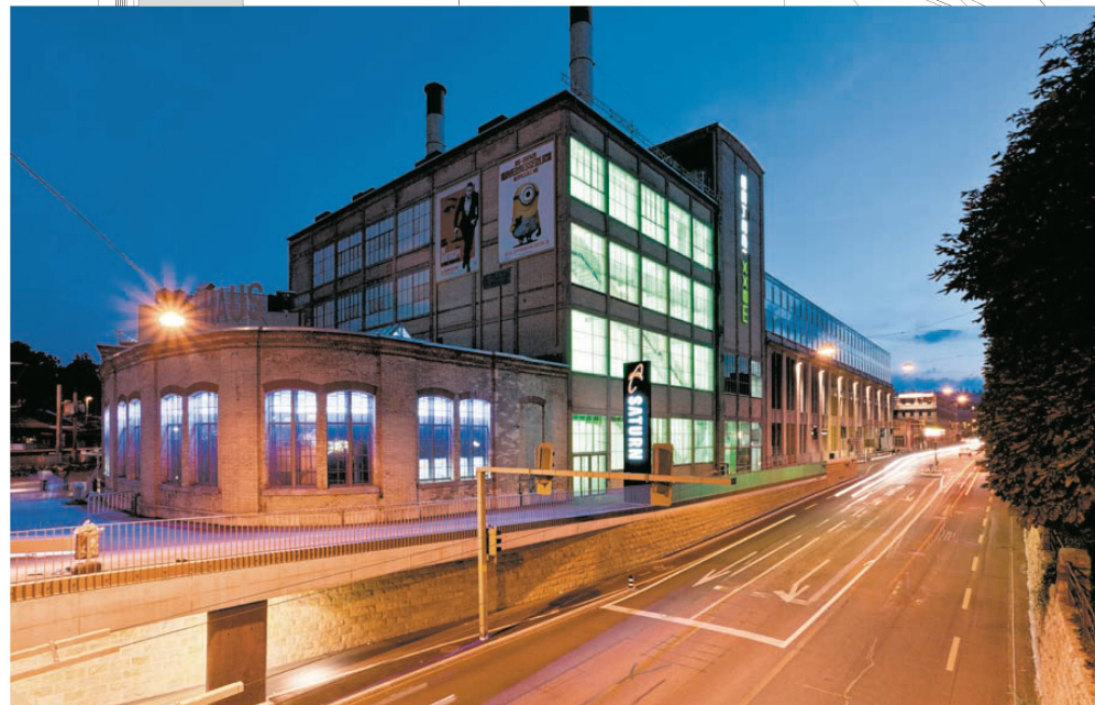
^ Auftakt und Wahrzeichen des Sulzer-Areals Winterthur: das Kesselhaus mit dem grün leuchtenden Treppenraum.
