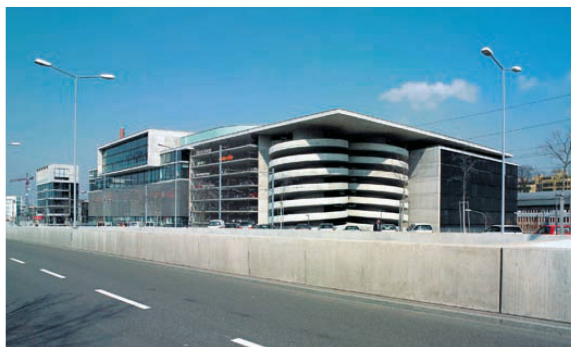
^Sihlcity, Zürich, 2007: Der Bau ist gross, doch Theo Hotz gliederte das Volumen und die Nutzungen sind ablesbar. Fotos: Ralph Bensberg
