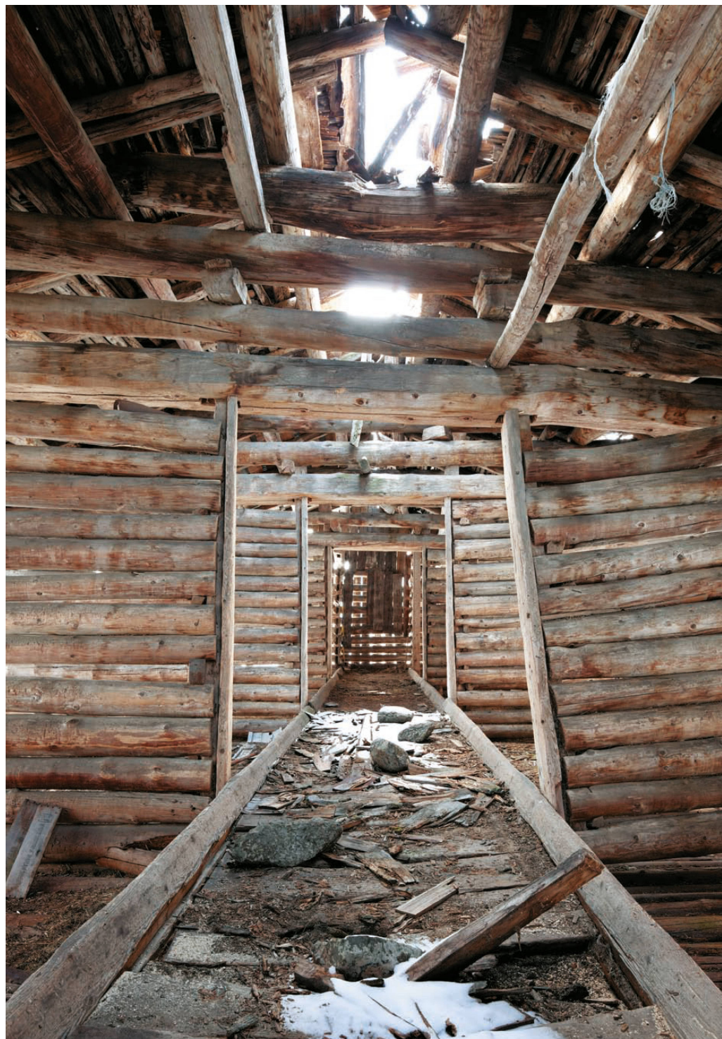
<1_400 Fichtenstämme wurden verbaut, das Holz für die Schindeln und die 300 dünnen Hälblinge des Schwarzdachs nicht eingerechnet.
