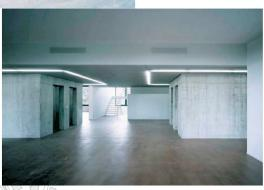
^Am Boden von Gängen und Büros liegt ein rotbrauner Holzzement, in der Eingangshalle und bei den Liftvorplätzen ein geschliffener Gussasphalt.
