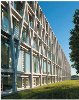
^Aus Betonelementen zusammengesetzte Bäume bilden das äussere Tragwerk des Schulhauses in Carouge bei Genf.
