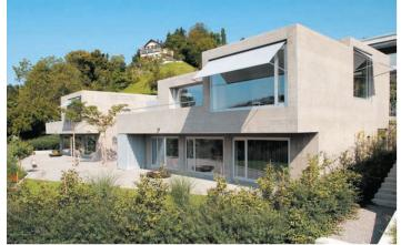
Nicht nur Fassade: Die Betonkonstruktion des Doppelhauses in Winterthur trägt, dämmt und stabilisiert den Hang
