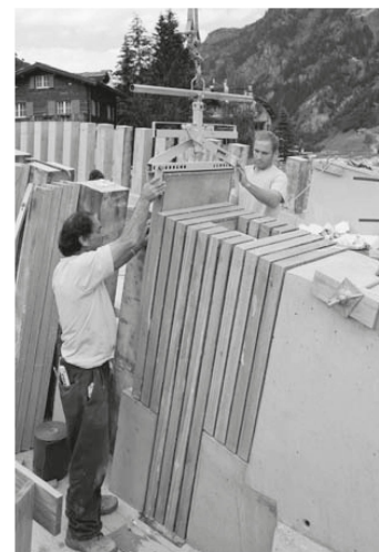
^Die 64 Millimeter starken Steinplatten umschliessen die leicht konischen Betonpfeiler.
