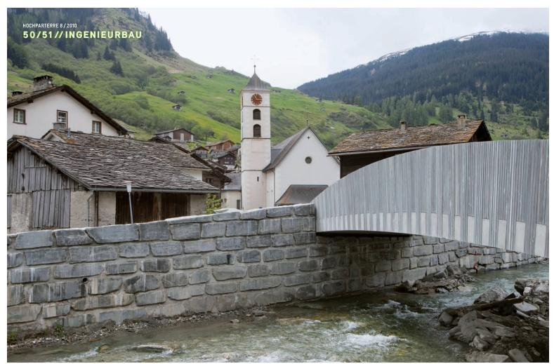
^Ein Stein, zwei Zustandsformen: Fein und scharfkantig bei der Brücke, wuchtig und unregelmässig bei der Mauer.
