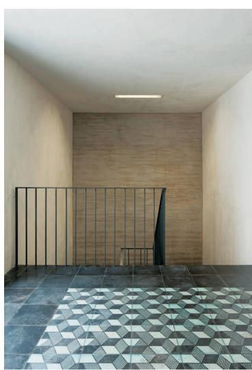
^Oberflächenstimmung: handgefertigte Bodenplatten, Stampflehmwand und seitliche Wände aus Lehmputz.
