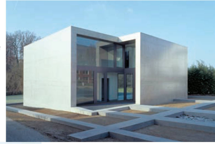
^ 19_Einfamilienhaus Findling, Möriken.
