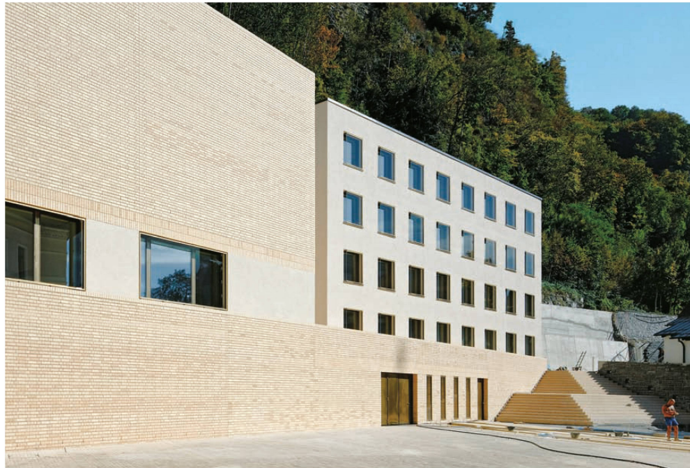
^ In der Klinkerfassade des Archiv- und Verwaltungsgebäudes in Vaduz zeichnet sich die verputzte Benutzerzone mit grossen Fenstern ab. Rechts davon steht der Verwaltungstrakt.
