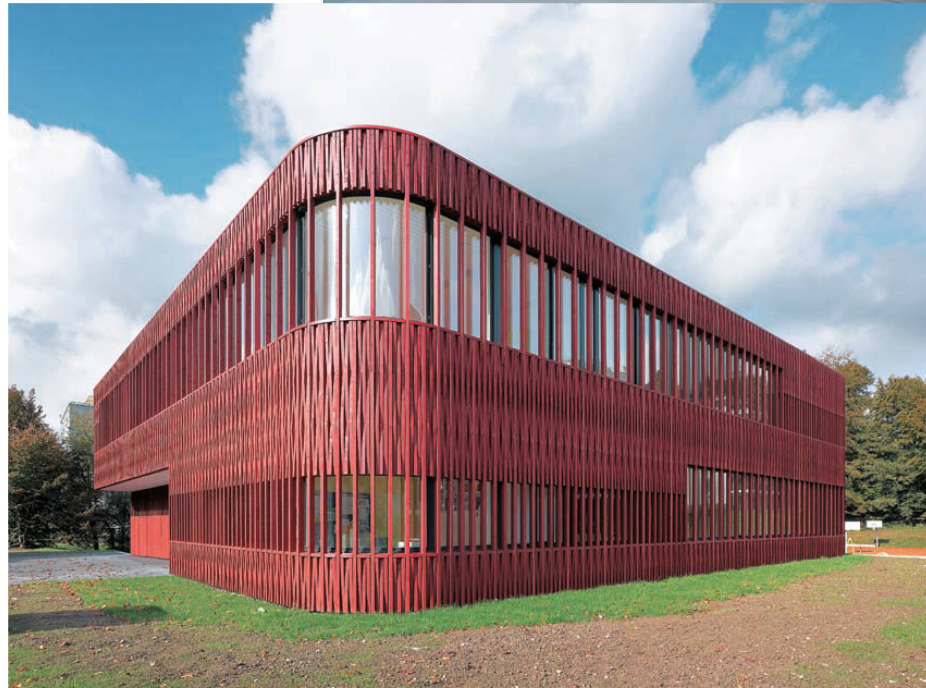
^Flirrender Holzteppich: Die Holz-Elementfassade besteht aus weinroten Tannenholz-Latten, jeweils einmal leicht nach innen und einmal leicht nach aussen geknickt.
