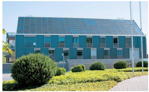
^In der Form unauffällig, aber in der Materialwahl besonders: Das Plusenergiehaus mit seiner Kollektorenfassade und dem entspiegelten Photovoltaikdach.
