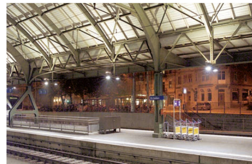
^Siebzig Prozent des Lichtes wird auf die Perrons gerichtet, dreissig Prozent erhellen das Hallendach und indirekt den Raum.
