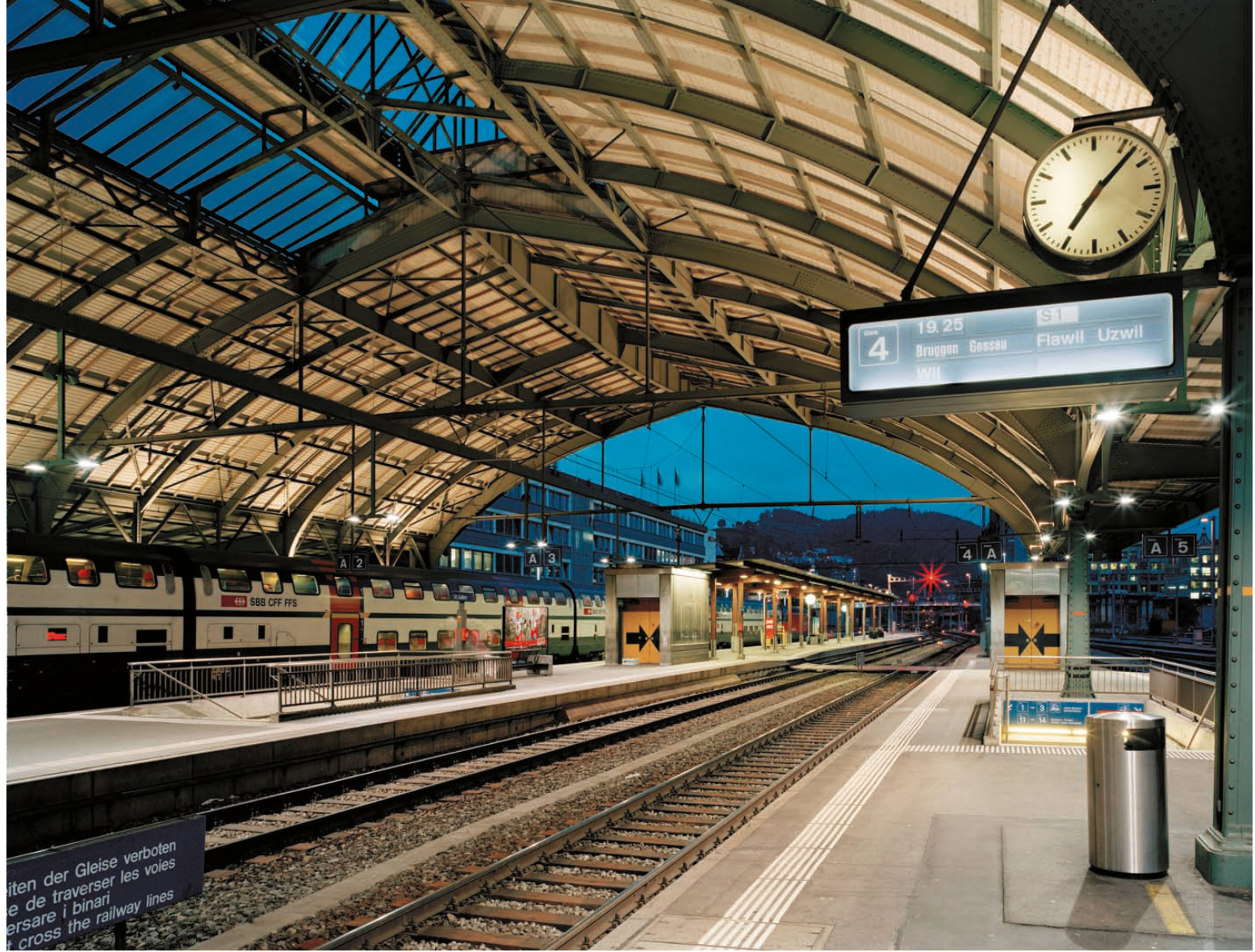
^Leuchtende Perronkanten und über allem ein dezent erhelltes Dach.
