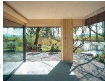
➤55_Sommerhaus: einer von acht massiven Lärchenpfählen.
