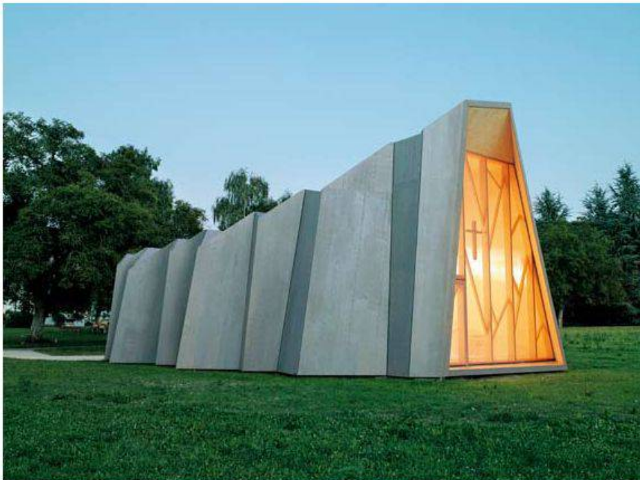
➤4_ Chapelle provisoire de Saint-Loup, Pompaples; structure porteuse pliée.
