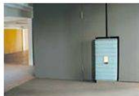
^ | Der Pelletofen am Eingang heizt das ganze Gebäude
