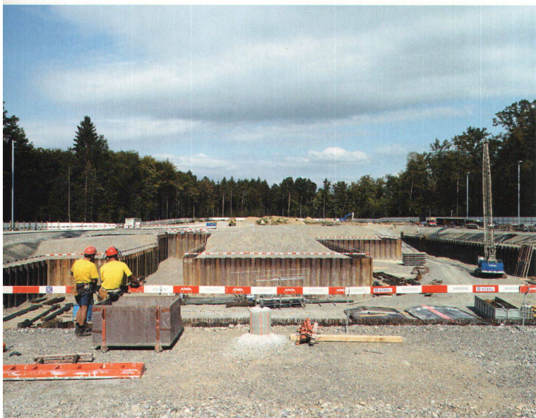
^5 Baustelle Kehrichtverwertungsanlage KVA Forsthaus West: Am Rand des Grossen Bremgartenwaldes entsteht mit der KVA ein 310 Meter langer Supertanker.
