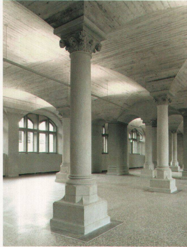
^Das sanierte Gewölbe im Erdgeschoss wurde zu «Galerie Sammlungen». Foto: Roman Keller
