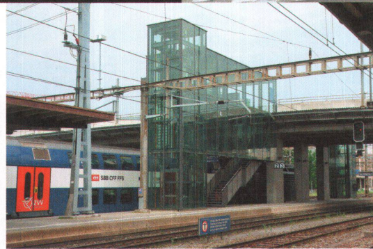
^8 Schlieren: Treppe und Lift verbinden Bahn und Bus.
