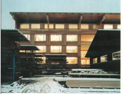
^ Der konstruktive Holzschutz ist mit eingebaut: Verrottete Teile lassen sich leicht ersetzen.
