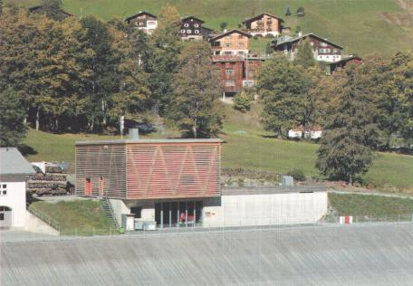
→ Bretter zu Nagelbindern gefügt worden. Eine Technik, die ohne die aufwendige Maschinerie fürs Leimen auskommt. Die Dachfläche konstruierte das Planerteam aus einer geschlossenen Bohlenlage und einer quer dazu laufenden geschlossenen Schalung, die als Scheibe die Querkräfte gleichmässig auf die Wände abgibt. Die Fassade aus Holzlamellen schützt die Tragkonstruktion vor der Witterung, lassen sie aber gleichwohl hindurchscheinen.
