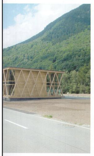
als tragende Holzständerkonstruktion aus einheimischer Tanne. Darauf liegt die Geschossdecke aus grossflächigen Holzkastenelementen. Identisch sind Obergeschoss und Dach aufgebaut. Die Aussenwände sind gleichzeitig die Klimagrenze, in der die fest verglaste Fassade sitzt.
