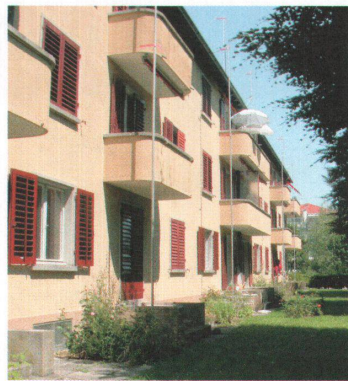
1 Das Haus vor der Sanierung: 18 kleine Zweizimmerwohnungen mit schmalen Balkonen. Fotos: Michael Fritschi, foto-werk.ch
