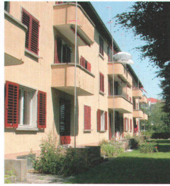
1 Das Haus vor der Sanierung: 18 kleine Zweizimmerwohnungen mit schmalen Balkonen. Fotos: Michael Fritschi, foto-werk.ch
