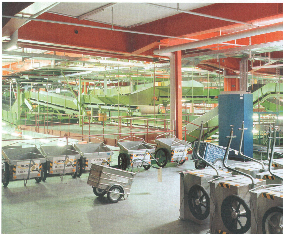
1 Die Förderanlagen im alten Paketzentrum Schanzenpost warten auf die Demontage; demontiert wird später auch das Gebäude.
