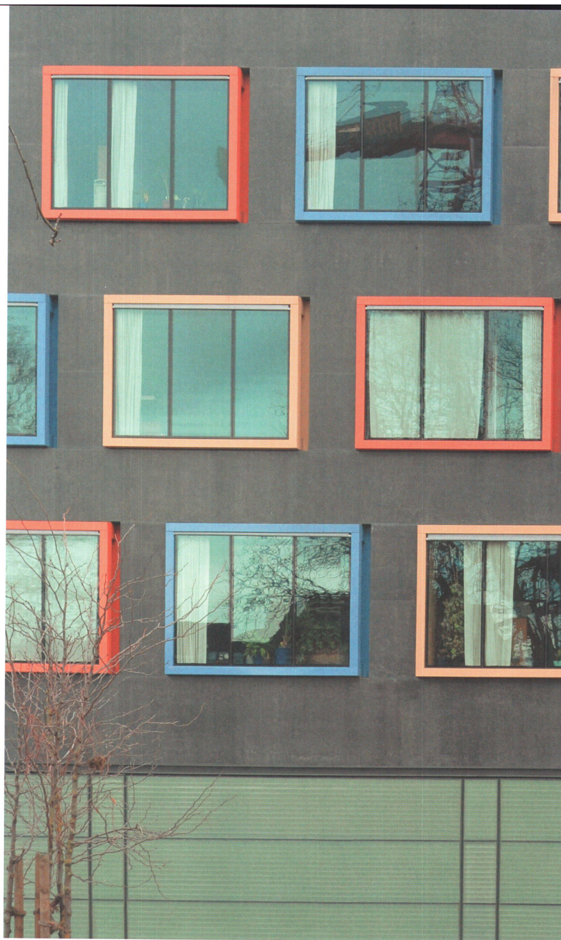
Winterthur, Hermann-Götz-Strasse: Der dunkle Betonkörper mit den farbigen Fenstereinfassungen ergänzt das Bezirksgebäude aus den Sechzigerjahren.
