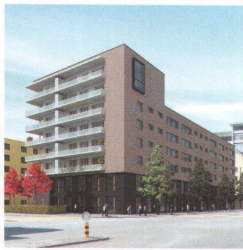
Überbauung Am Martinsberg, 2007 42
