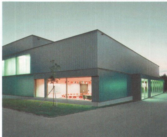
1 Blaigrün schimmert die Fassade: die Turnhalle als Glashaus – mal transparent, mal transluzent. Fotos: Roger Frei
