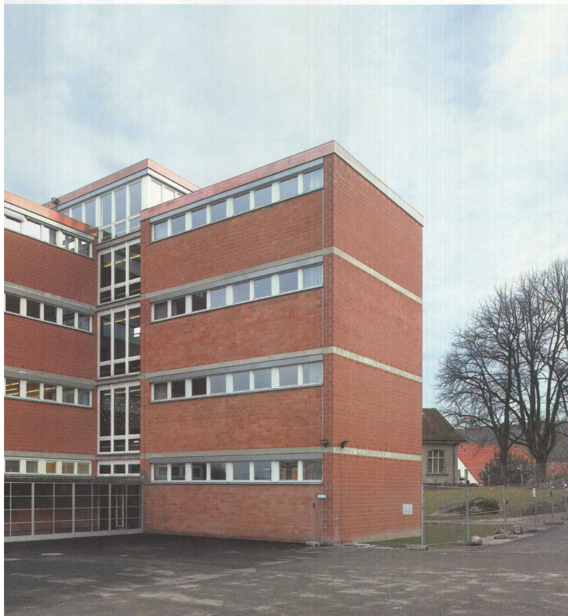
Die neu aufgemauerten Westfassaden (nach rechts blickend) sind homogener und etwas dunkler als die Originalfassaden.
