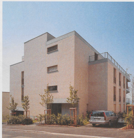
3 Zur Strasse hin gibt sich das Haus verschlossen, denn das Zweischalenmauerwerk hält die Wärme im Gebäude.
