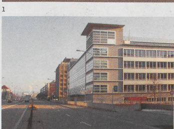
1 Die zweischichtige Konstruktion aus weissem und grünem Glas macht die Boxen kaum fassbar. Foto: Andrea Helbling
