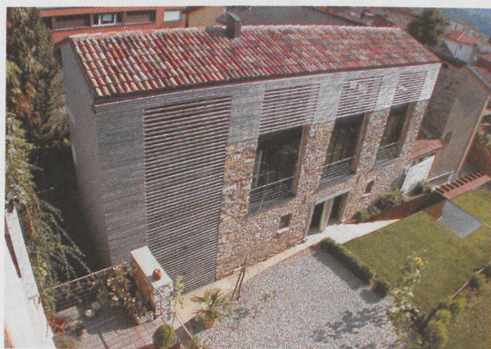
1 Im Innern ist Bruchsteinmauerwerk sichtbar; das milde Klima machte Konzessionen an die Dämmung möglich.
