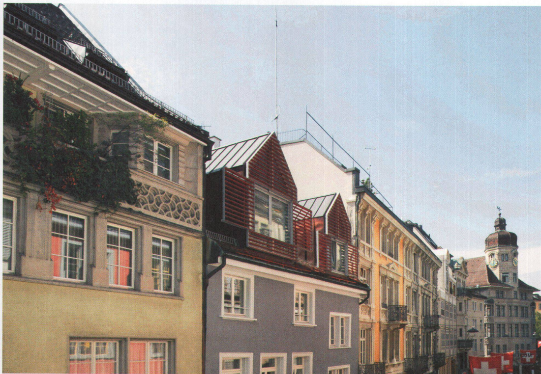
In der St. Galler Altstadt sind alle vor 1920 gebauten Gebäude geschützt. Mit viel Diskutieren bekam der Architekt Marcel Ferrier die Dachaufbauten bewilligt, die in der Volumetrie den in den Sechzigerjahren abgebrochenen Lukarnen entsprechen.
