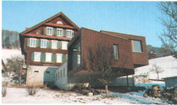
Anbau Bauernhaus Hostatt, Stalden
