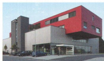
Gewerbe- und Bürogebäude, 2003 Grossweid, Rain --> Bauherrschaft: René Leuenberger, Sursee --> Architektur: W. & R. Leuenberger, Sursee --> Holzbau: Tschopp Holzbau, Hochdorf
