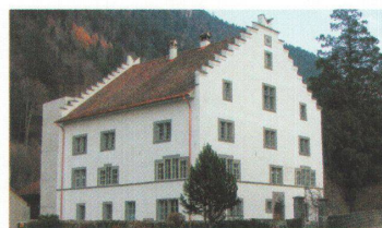
Restaurierung Suworowhaus, 2006 Altdorf --> Bauherrschaft: Stiftung Karl Jauch, Altdorf --> Architektur: Werner Furger, Altdorf --> Holzbau: Bissig, Altdorf; Schuler, Bürglen; Furger, Bristen
