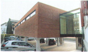
Anbau Bürogebäude, 2005 Sarnen
