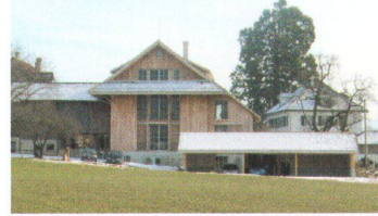
Ersatzbau Scheune, 2005 Rifferswil
