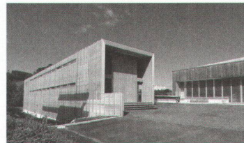
Bürotrakt, Lagerraum, Bau 4, 2005 Kreuzmatte, Altbüren --> Bauherrschaft: Schaerholzbau AG, Altbüren --> Architektur: Blum und Grossen- bacher Architekten, Langenthal --> Holzbau: Schaerholzbau AG, Altbüren
