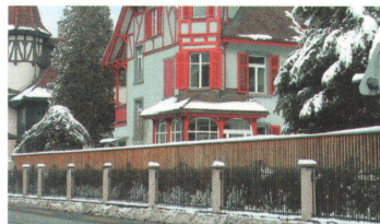
Lärmschutzwand Haus Grüneck, 2003 Horwerstrasse, Luzern --> Bauherrschaft: Lotti und Thomas Marti Schindler, Luzern --> Architektur: GMT Architekten, Thomas Marti, Luzern --> Holzbau: Erwin Häcki Holzbau, Horw
