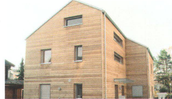
Umbau Wohnhaus, 2005 Hertistrasse, Brunnen
