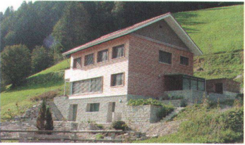
Einfamilienhaus (Passivhaus), 2005 Escholzmatt --> Bauherrschaft: Familie Stamm- Strässle, Escholzmatt --> Architektur: CAS Chappuis Aregger Solèr, Willisau/Luzern/Altdorf --> Holzbau: Burch AG, Sarnen
