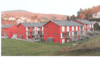
Minergie-Holzbau-Siedlung, 2004 Im Winkel, Affoltern am Albis
