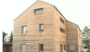
Umbau Wohnhaus, 2005 Hertistrasse, Brunnen
