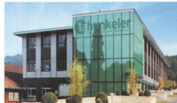
Erweiterungsbau 1a hunkeler, 2004 Bahnhofstrasse, Ebikon --> Bauherrschaft: 1a hunkeler, Der Fenster- und Holzbauer, Ebikon --> Projek, Planung und Ausführung: Kader der 1a hunkeler, Ebikon
