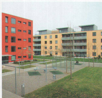
Überbauung Binzhof VI 56
