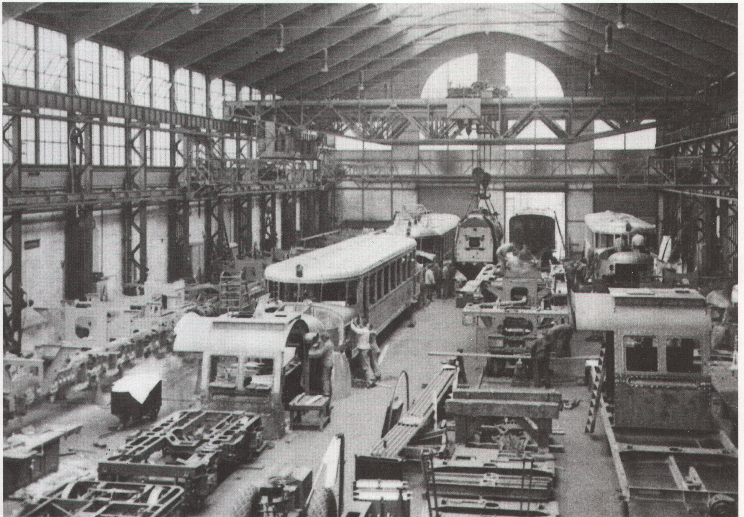
1 Produkte aus Winterthur für den Weltmarkt: Die heute noch der Lokomotivausbesserung dienende Montagehalle der SLM 1935 mit «Roten Pfeilen», «Tabakloks» für Bulgarien und «Ellok» für Südafrika. Foto: Sammlung Hans-Peter Bärtschi
