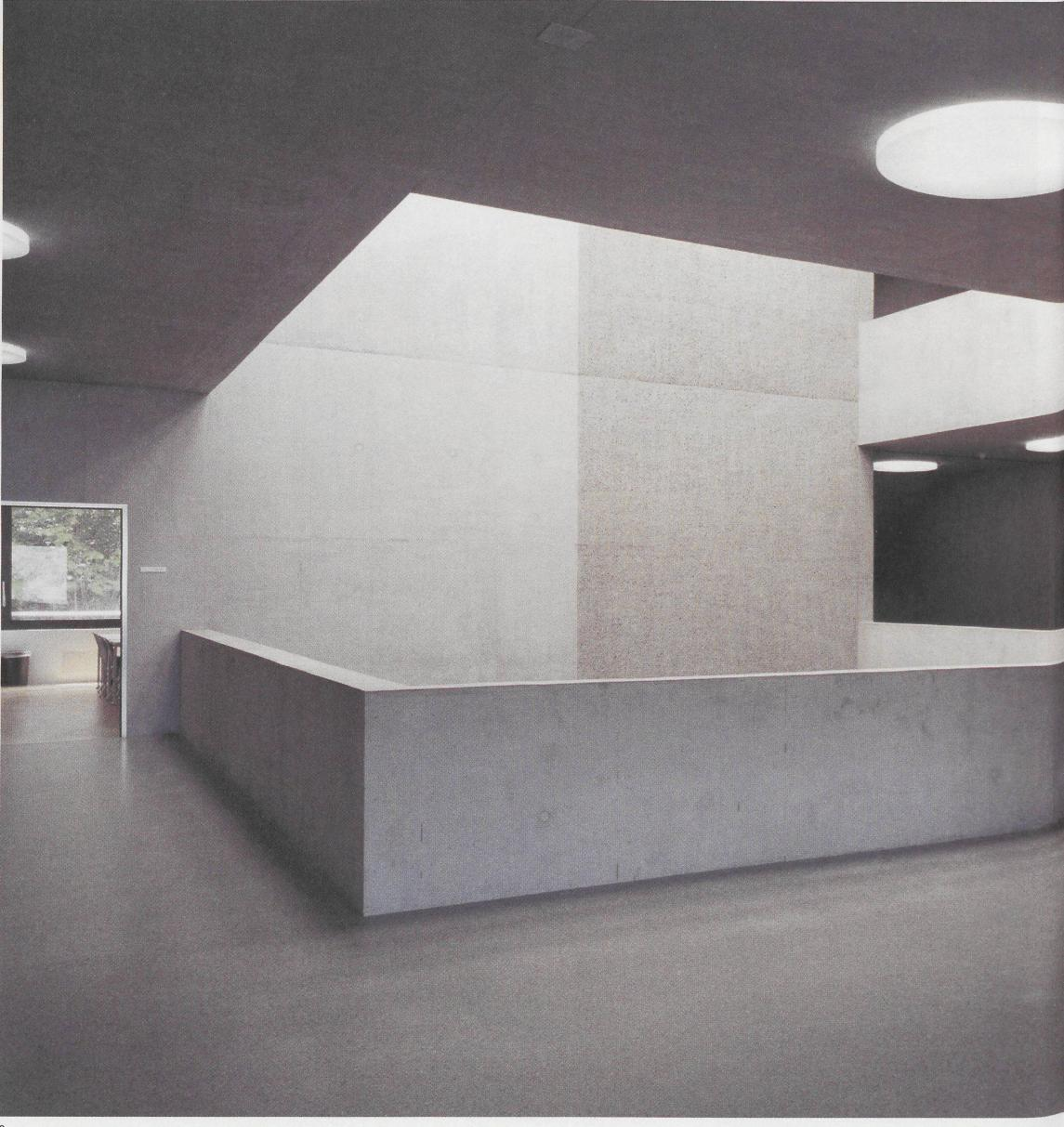
scher Beton war von Anfang an der Wunsch der Architekten und die Auskragung über dem Erdgeschoss hätte eine andere Konstruktion gar nicht zugelassen. Erst als die letzte Wand und die letzte Decke betoniert waren, durfte man die Spriessen unter der Auskragung entfernen.
