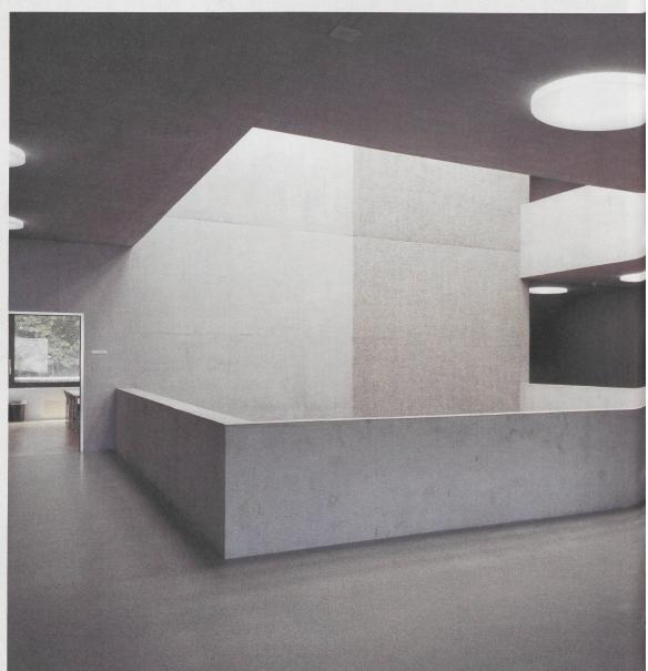
scher Beton war von Anfang an der Wunsch der Architektinnen und die Auskragung über dem Erdgeschoss hätte eine andere Konstruktion gar nicht zugelassen. Erst als die letzte Wand und die letzte Decke betoniert waren, durfte man die Spriessen unter der Auskragung entfernen.
