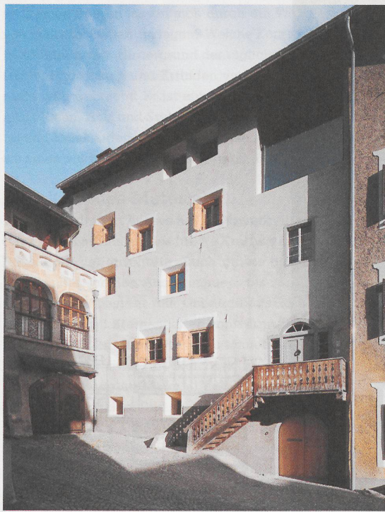
1 Die Chesa Madalena steht quer zur Gasse in Zuoz. Ein grosses Fenster verkündet die Umnutzung zur Galerie. Das Loch dafür existierte, doch war es mit Holz verschalt.
