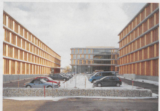
4 Das Lamellensystem mit den verschiedenen fixen Bestückungen: Glas, Holzfüllung und noch feinere Lamellen im EG.
