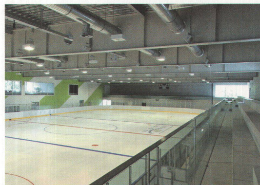
3 Dominiert aussen der Beton, so prägen im Innern die Stahlträger und das Profilblech der Dachkonstruktion den Raum.
