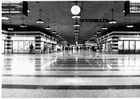
1983–1990: Bau der S-Bahn
