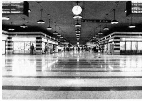
1983–1990: Bau der S-Bahn
