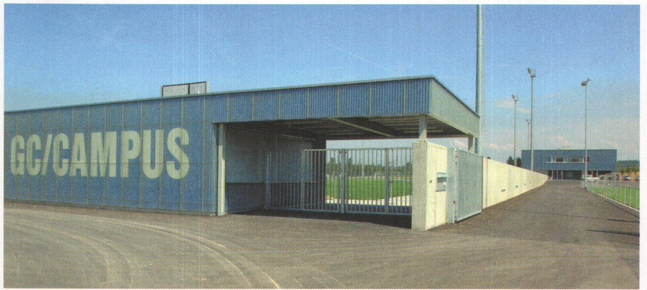
1 Ein lange Betonmauer verbindet die mit Well-Kunststoffplatten verkleideten Gebäude miteinander. Foto: Mischa Scherrer
