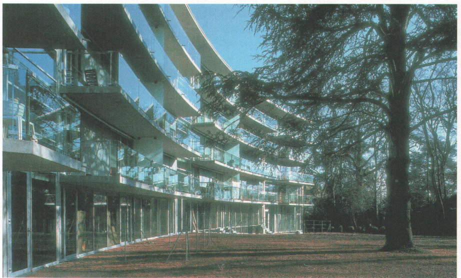
1 Die mitten auf dem Grundstück stehende Zeder bestimmte die Ausrichtung des Mehrfamilienhauses. Foto: Adrian Scheidegger
