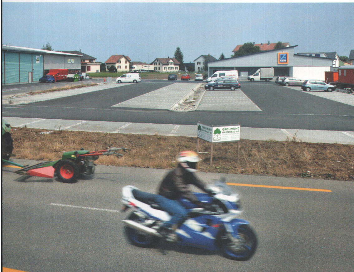
Discounter in Oberaach TG: architektonisch gesichtsloser, anspruchsloser Zweckbau und rundum asphaltierte Landfläche.
