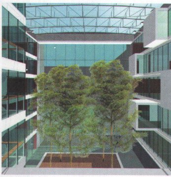
Bürogebäude PricewaterhouseCoopers, (im Bau) (19, Seite 12)
