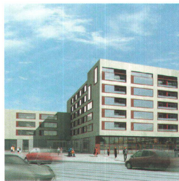
Wohn- und Geschäftshaus Max-Bill-Platz (im Bau) (17, Seite 12)
