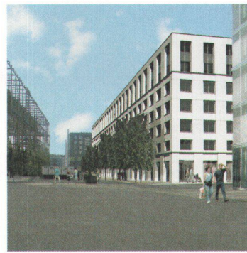
Wohn- und Geschäftshaus Ententeich (im Bau) (24, Seite 13)
