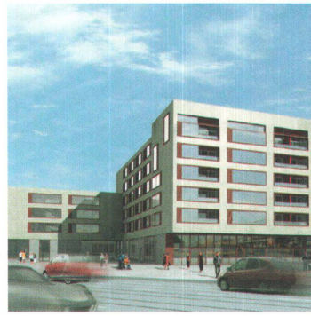
Wohn- und Geschäftshaus Max-Bill-Platz (im Bau) (17, Seite 12)
