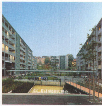
Wohnüberbauung Regina-Kägi-Hof (27, Seite 12)
