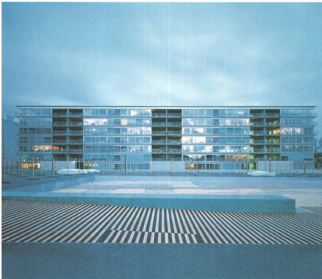
Wohnüberbauung Am Park (11, Seite 12)
