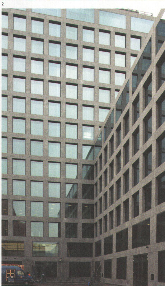
1-3 Mit seiner Ansicht, Stein stehe «für Solidität, Glas für Weltoffenheit» überzeugte Max Dudler IBM und erhielt den Auftrag für den neuen Hauptsitz von IBM Schweiz in Zürich-Altstetten. Realisiert wurde der Bau vom Generalunternehmen Allreal.
