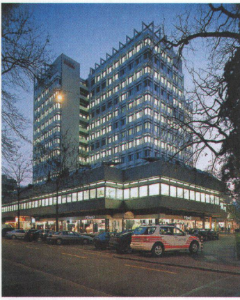
1 Das Hochhaus zur «Palme» (1964) erhebt sich über einem eigenständigen Sockelbau. Nach der Idee der Planer hätten im Quartier mehrere «Palmen» entstehen können.
