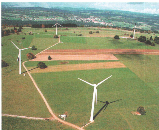
Technik dominiert die Landschaft: Auf dem Mont Soleil steht schon ein Windkraftwerk und es wird noch erweitert.
