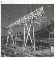
Stützen die Wind- und Erdbebenkräfte aufnehmen. Zwei durch alle Geschosse hindurchgehende Fugen teilen das Airside Centre in drei Abschnitte. Im Computer wurde das Erdbeben simuliert und man fand heraus, dass sich die drei Abschnitte unterschiedlich bewegen, was aus ihrer verschiedenen Form zu erklären ist. Doch nicht das Erdbeben macht den Ingenieuren am meisten Sorgen, sondern die Dilatation. Die Anschlüsse an die bestehenden Bauten erwiesen sich als überaus schwierig.
