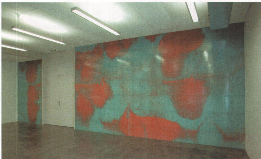
1 Das Wandgemälde des Künstlers und Architekten Christoph Haerle ist nicht auf den Beton aufgetragen, sondern in den Gussstein hineingemischt. Fotos: Hansruedi Riesen
