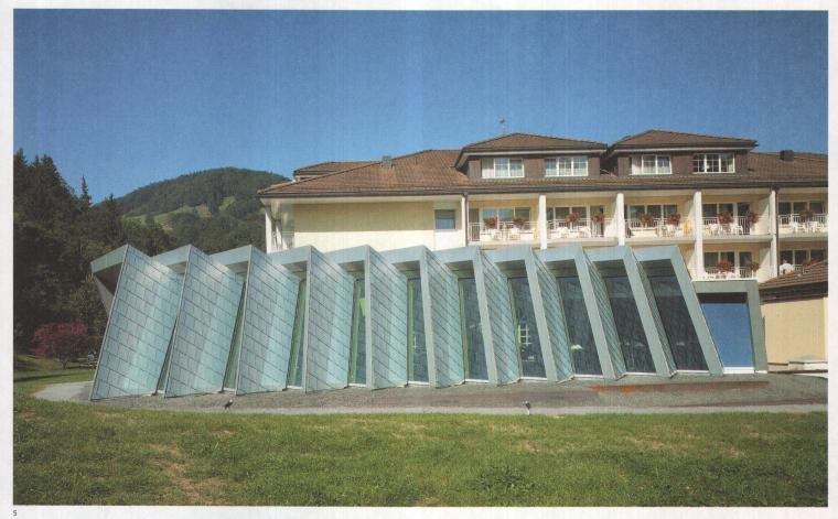
→ wirkt die Struktur offen oder geschlossen. Jedes der elf identischen Elemente verfügt über eine eigene Entwässerung und kann direkt ans Strom- und Lüftungssystem angeschlossen werden. Pro Tag wurden sechs Elemente einzeln per Lastwagen von Herisau nach Weissbad gefahren und mit dem Kran an ihren Platz gesetzt. Die Planungszeit dauerte fünf Monate, der Aufbau der Hülle vier Wochen.
