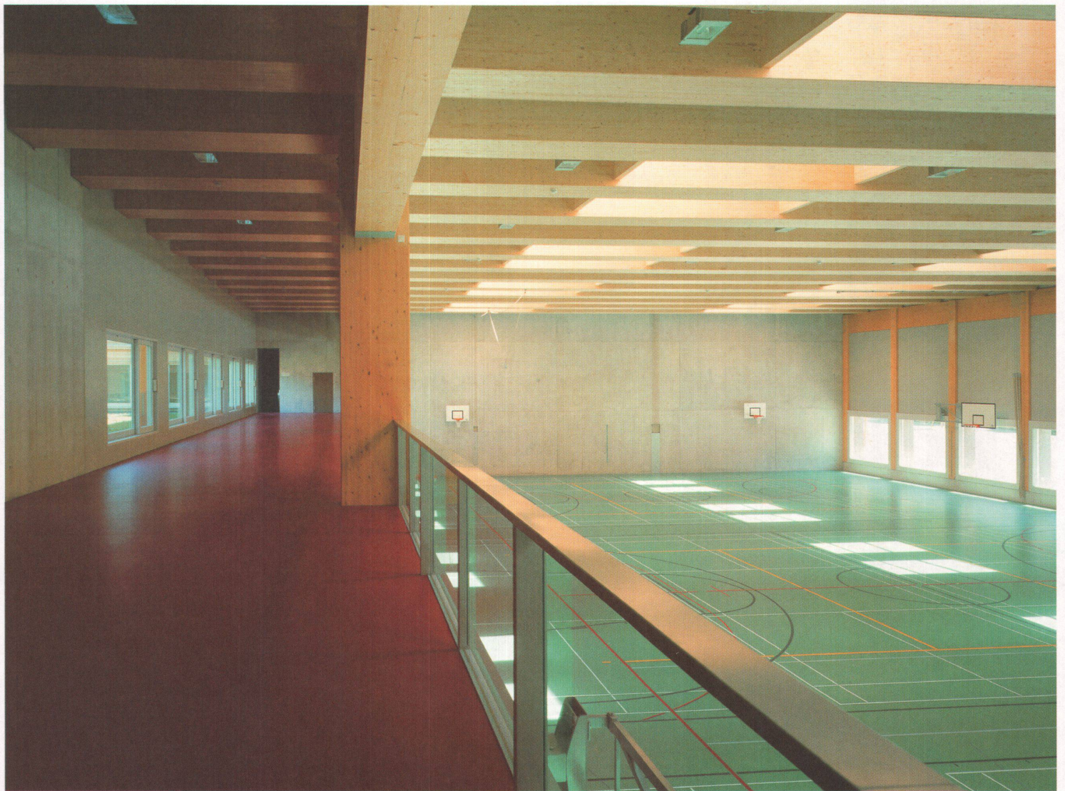
2 In der Turnhalle der Geländesprung: Die Galerie liegt auf Hofniveau, die Aussenfassade der Sporthalle ein Geschoss tiefer.
