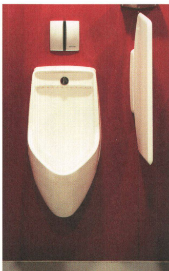
1 Dank Radarsteuerung auch im Olma-Messe-Hochbetrieb immer saubere Pissoirs.
