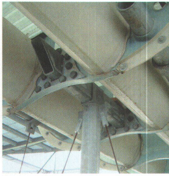
1 In der Untersicht sieht man, wie die Stahlstützen mit der eigentlichen Brücke verbunden sind.
