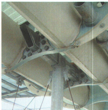
1 In der Untersicht sieht man, wie die Stahlstützen mit der eigentlichen Brücke verbunden sind.
